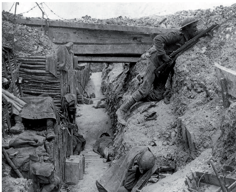
Vue d'une tranchée anglaise en 1916
